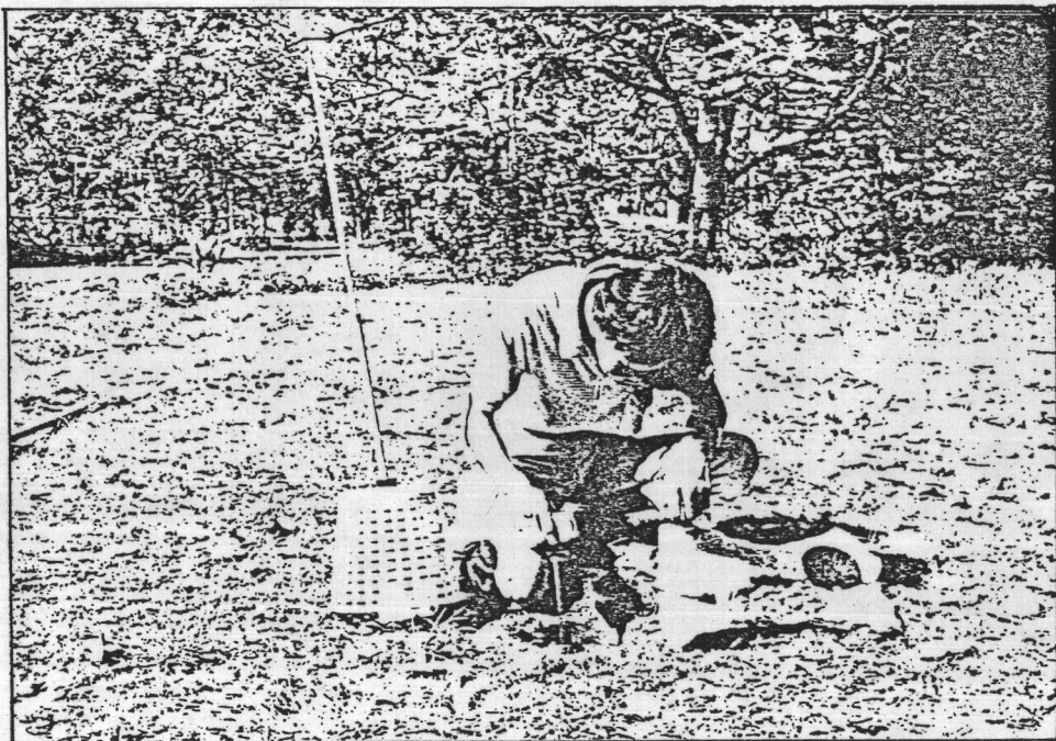
รูปที่ 3:8 ตรวจสอบระดับของกรวดหยาบ
