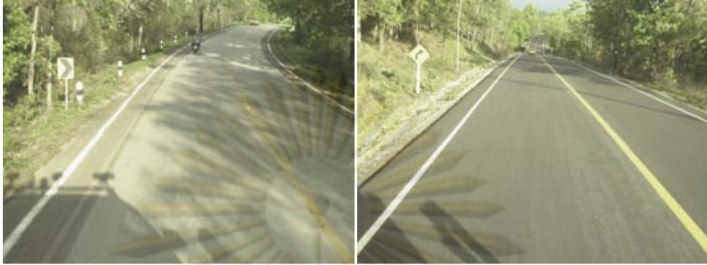
รูปที่ 4.15 ตัวอย่างป้ายจราจรที่มีแสงตกลงบนพื้นผิวมากเกินไป
