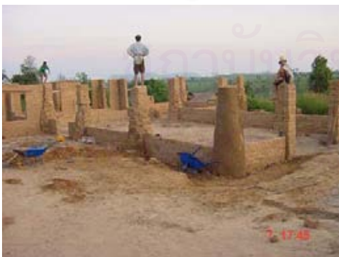
ภาพที่ 4-31 แสดงแนวท่อรอบอาคารเพื่อระบายน้ำ ที่มา : บันทึกเมื่อ 7 พฤศจิกายน 2545
