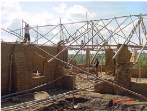
ภาพที่ 4-50 แสดงชาวบ้านสร้างโครงหลังคา ที่มา : บันทึกเมื่อ 14 พฤศจิกายน 2545
