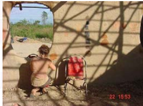
ภาพที่ 4-63 แสดงการทดลองฉาบสีผนัง ที่มา : บันทึกเมื่อ 22 พฤศจิกายน 2545
