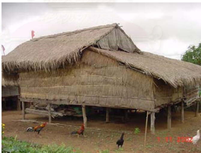
ภาพที่ 2-1 แสดงเรือนเครื่องผูกใช้หญ้าคา
