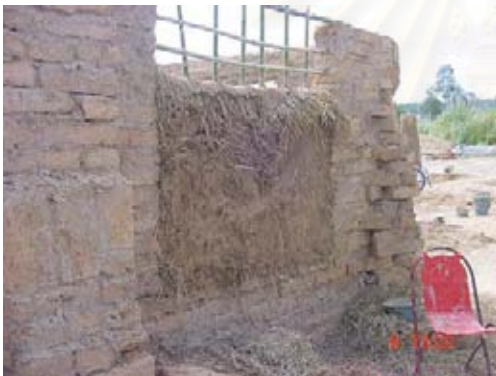
ภาพที่ 4-33 แสดงวิธีการก่อสร้าง Wattle and daub ที่มา : บันทึกเมื่อ 8 พฤศจิกายน 2545
