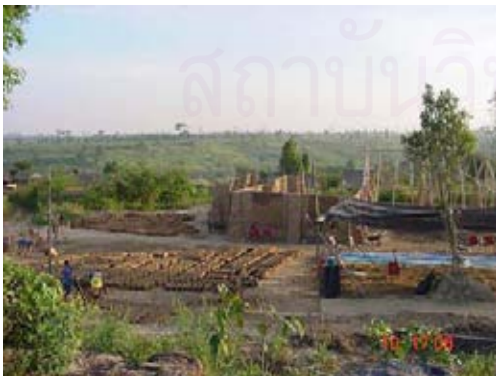
ภาพที่ 4-40 แสดงโครงหลังคาและบริเวณตากอิฐดิน ที่มา : บันทึกเมื่อ 10 พฤศจิกายน 2545
