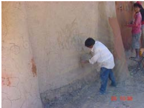
ภาพที่ 4-72 แสดงการปรับผิวผนังภายนอก ที่มา : บันทึกเมื่อ 29 พฤศจิกายน 2545
