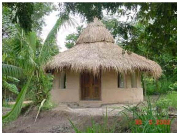
ภาพที่ 2-9 อาคารดินสำหรับนั่งสมาธิ อาคารมวงศ์สนิท ที่มา : บันทึกเมื่อ 30 พฤษภาคม 2545
