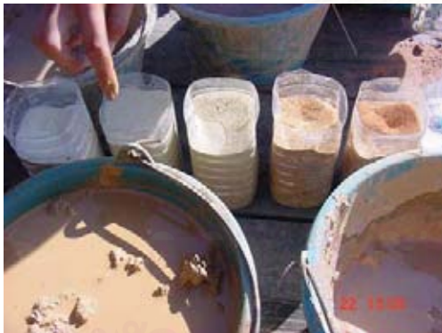
ภาพที่ 4-62 แสดงผสมสีฉาบผนัง ที่มา : บันทึกเมื่อ 22 พฤศจิกายน 2545
