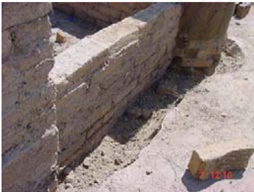
ภาพที่ 4-30 แสดงการขุดแนวท่อเพื่อระบายน้ำ ที่มา : บันทึกเมื่อ 7 พฤศจิกายน 2545
