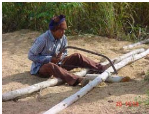
ภาพที่ 4-64 แสดงนายบุญศรี ทำโครงผนัง ที่มา : บันทึกเมื่อ 23 พฤศจิกายน 2545
