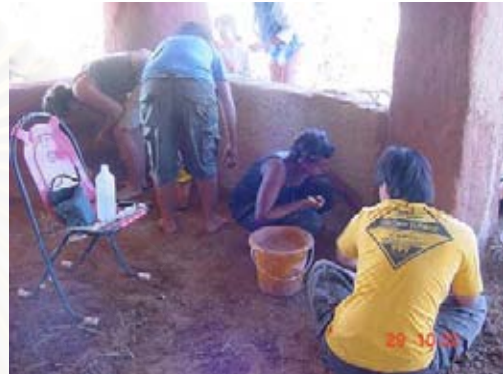
ภาพที่ 4-73 แสดงการฉาบปรับผิวผนังภายใน ที่มา : บันทึกเมื่อ 29 พฤศจิกายน 2545
