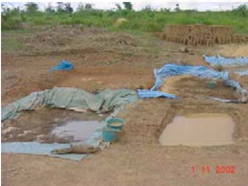
ภาพที่ 4-14 แสดงบริเวณที่ทำการผสมทำอิฐดิน ที่มา : บันทึกเมื่อ 1 พฤศจิกายน 2545
