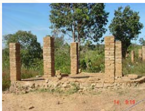
ภาพที่ 4-55 แสดงบ้านนายเหมือน เมืองขุนทด ที่มา : บันทึกเมื่อ 14 พฤศจิกายน 2545
