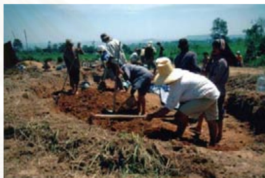
ภาพที่ 4-8 แสดงการขุดดินเพื่อทำอิฐดินดิบ ที่มา : บันทึกเมื่อ 14 ตุลาคม 2545
