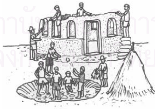
ภาพที่ 2-17 แสดงการทำปั้นดิน (Cob)
