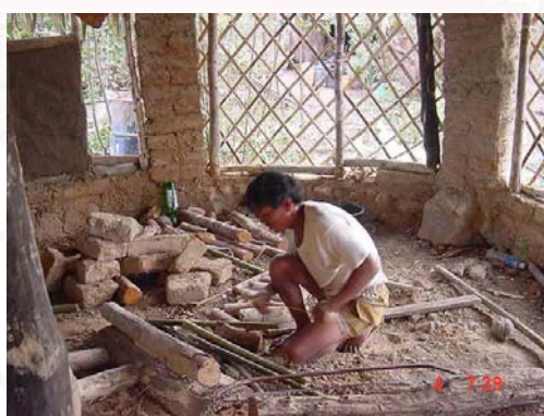
ภาพที่ 4-92 แสดงนายอุ๊ด ก่อสร้างบ้านตนเอง ที่มา : บันทึกเมื่อ 4 ธันวาคม 2545
