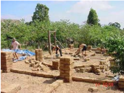
ภาพที่ 4-41 แสดงการก่อสร้างแนวเสาบ้าน ที่มา : บันทึกเมื่อ 11 พฤศจิกายน 2545
