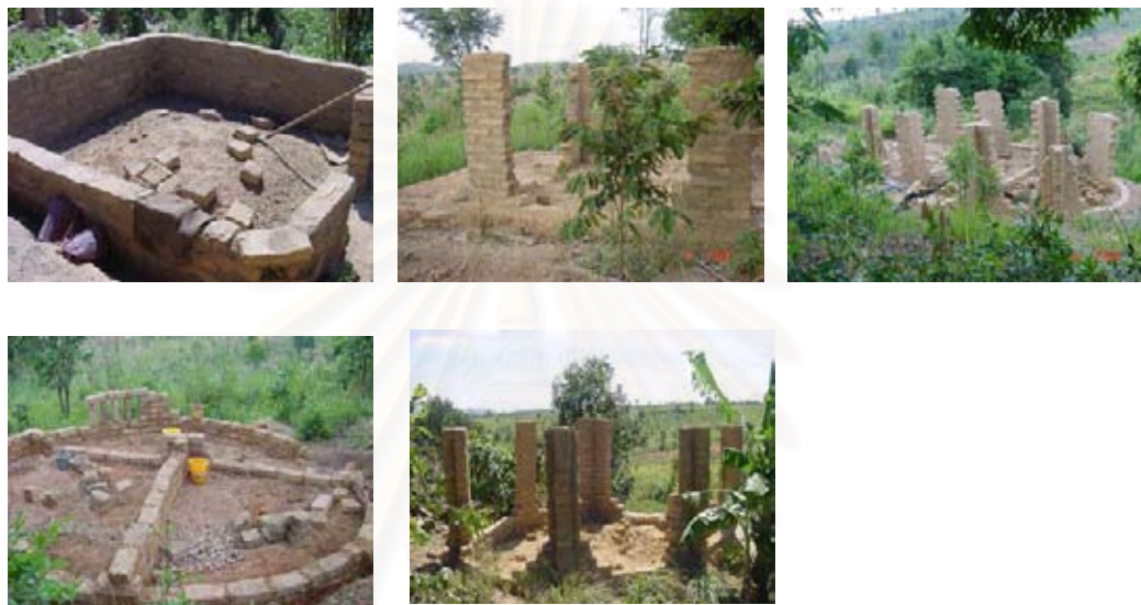
ภาพที่ 4-93 แสดงบ้านที่มีการก่อสร้างต่อไป
