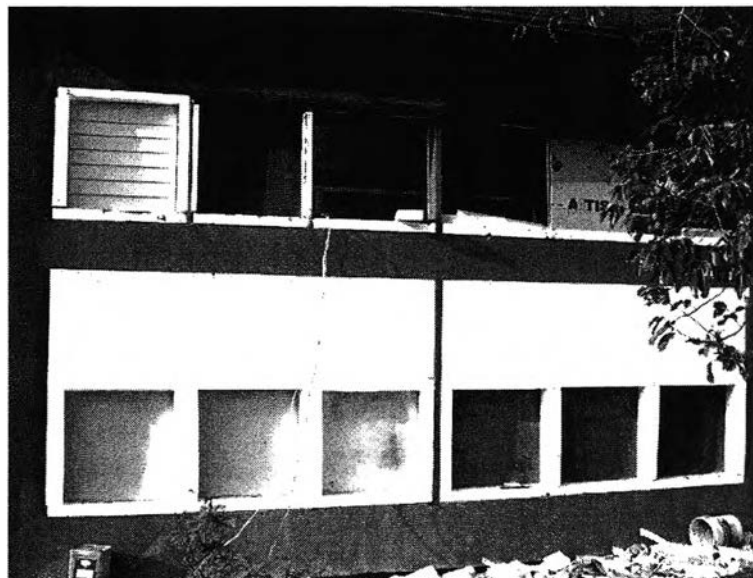
รูปที่ 3.14 การติดตั้งผนังทั้ง 3 ประเภท โดยติดตั้งบริเวณชั้น 2 ของห้องทดลองทั้ง 4 ทิศ
